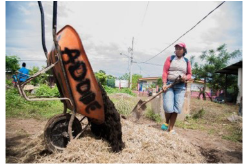
Fig. 11. Foto del proceso de mezclado manual. Fuente: Berrios, Carlos
