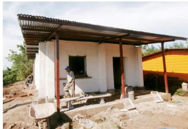
Fig. 4. Modelo de vivienda construida en el barrio con técnica reforzada de adobe. Año de construcción 2017. Fuente: Propia
