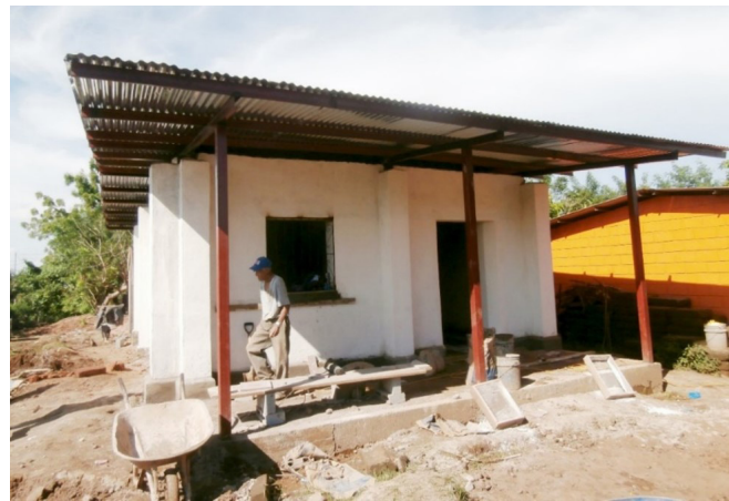
Fig. 4. Modelo de vivienda construida en el barrio con técnica reforzada de adobe. Año de construcción 2017. Fuente: Propia
